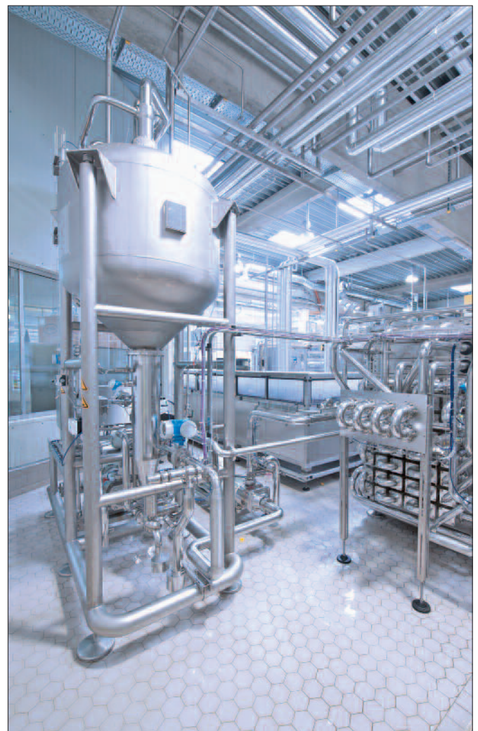
Abbildung 1: Produktentgaser integriert in eine thermische Produktbehandlung zur Heißabfüllung von Säften
